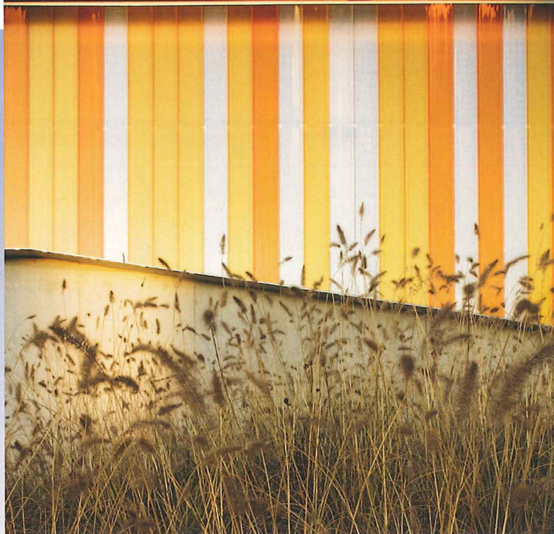
Façade de la halle aux camions en polycarbonate teinté.
