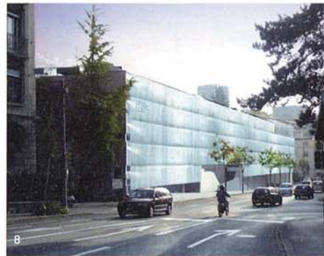
7 Renovierung und neue Fassade Chemiegebäude, EPFL, Polytechnische Universität, Lausanne 2008 // Reconfiguration and new façade for the Chemistry building, EPFL Polytechnic University, Lausanne 8 Neue Fassade für die „Clinique de la Source“, in Zusammenarbeit mit: John Armleder, RFR-Paris, Daniel Willi S. A., Lausanne 2007 // New Façade "Clinique de la Source", Lausanne in collaboration with: John Armleder, RFR-Paris, Daniel Willi S. A., Lausanne
