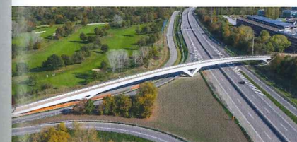
Passerelle Hôpital de Sion sur A9
