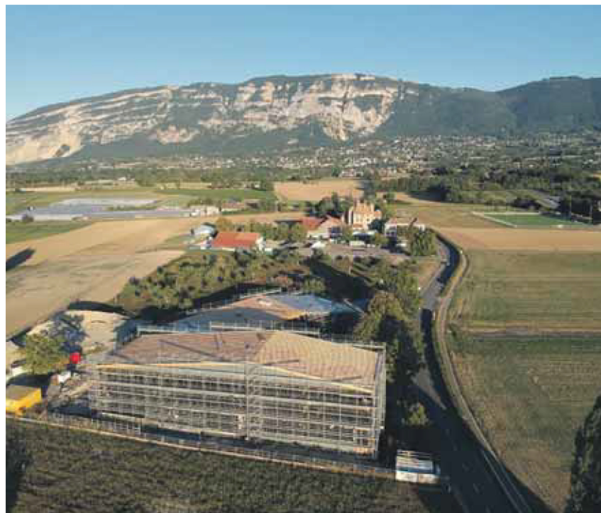
La nouvelle école sera opérationnelle pour la rentrée 2026. DITEQ SA
